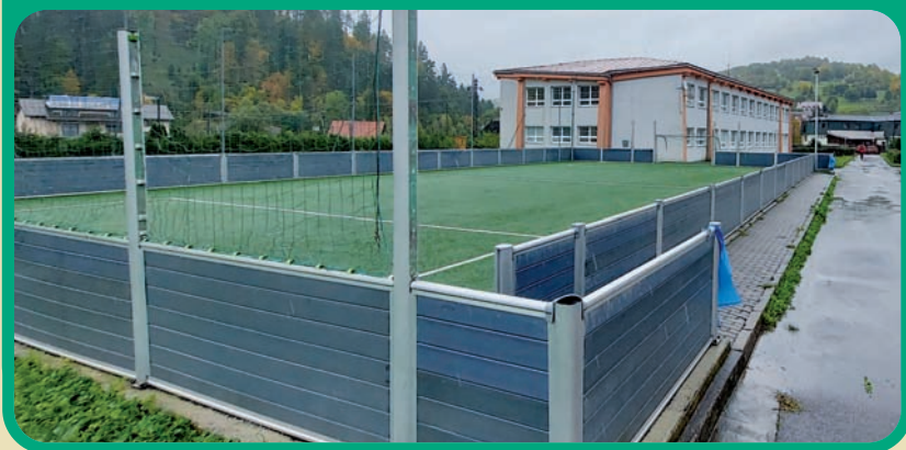
Začatá výstavba oddychového parku A. F. Kollára
